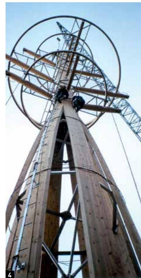
**4.** Ce pylône électrique haute tension de 31 m de hauteur est en pin lamellé-collé lasuré. Il est l'œuvre du célèbre designer Martin SZEKELY pour EDF en 1994.
